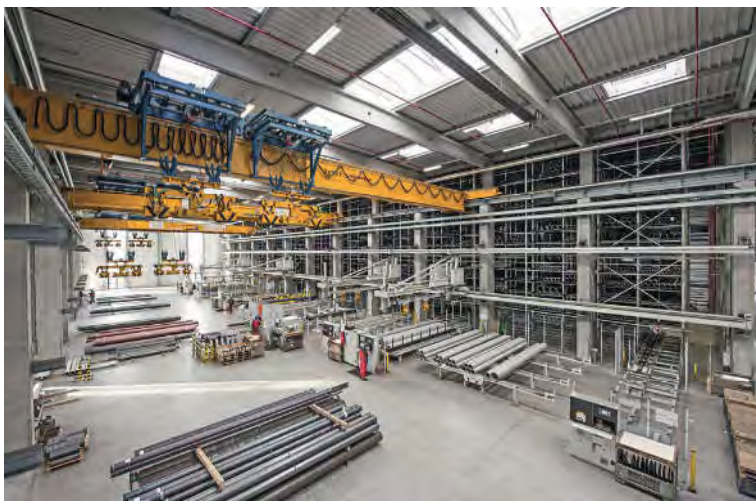
Im Zentrallager Beucha/Leipzig bevorratet rff Rohre aus C-Stahl und rostfreiem Edelstahl.
