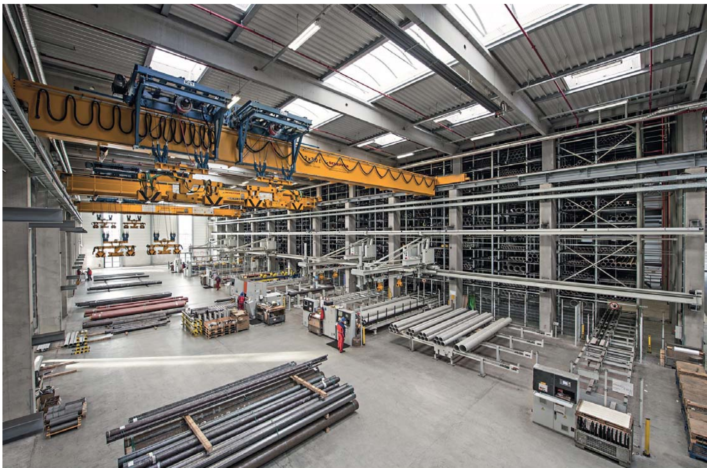
Das Zentrallager für Rohre in Beucha/Leipzig zeichnet sich unter anderem durch zwei automatische Kassettenlager aus.
